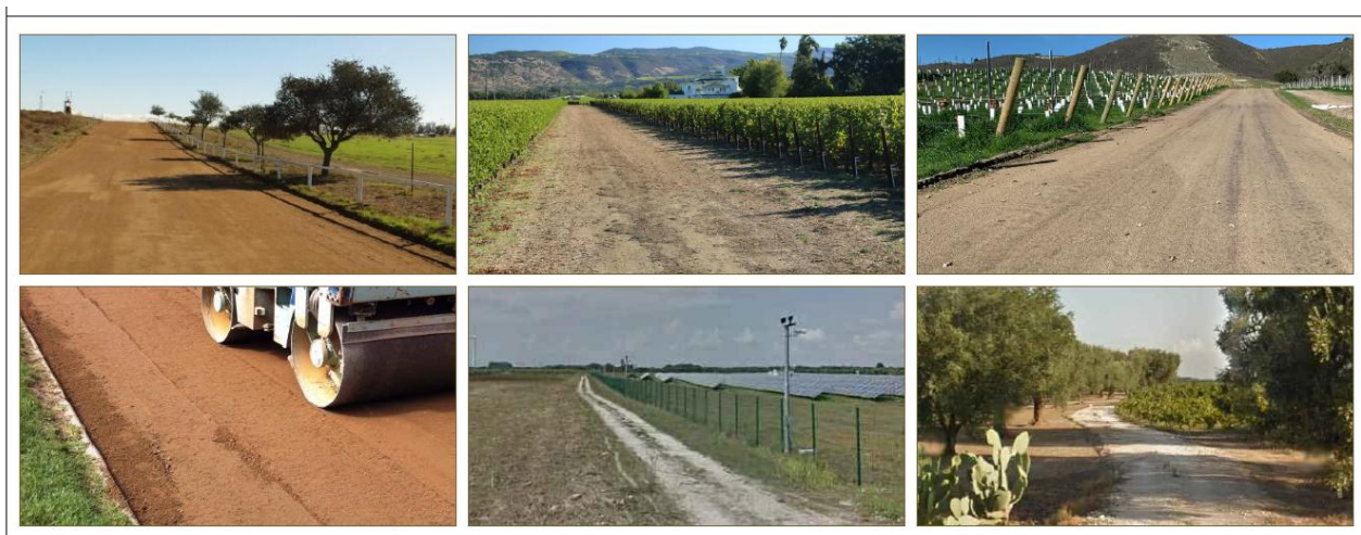
Figura 14-1 - Esempi di strade in terra stabilizzata
